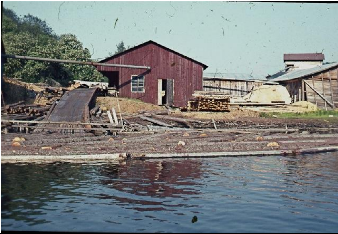
Mädans Såg – ”stupbron”, dvs uppdragning av timmer ur vattnet.
